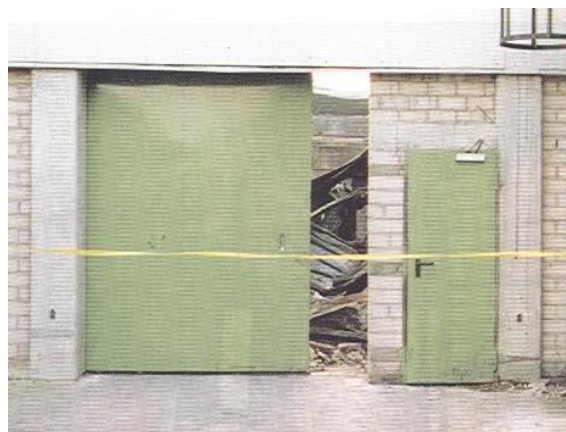
Slika 6-3: Neizpostavljen del objekta (vir: Promat d.o.o.)
