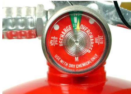
Slika 5-1: Primer tlačnega manometra na ročnem gasilniku
