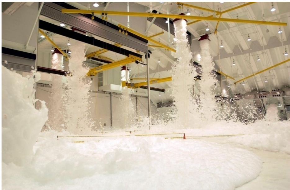
Slika 4-10: Aktiviranje sistema za gašenje s srednjo peno
