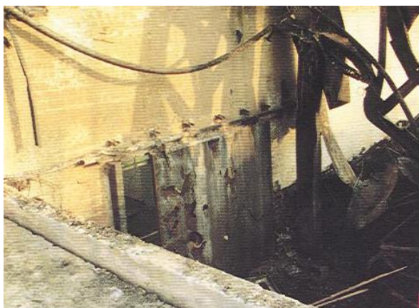
Slika 5-3: Izpostavljen del objekta (vir: Promat d.o.o.)
