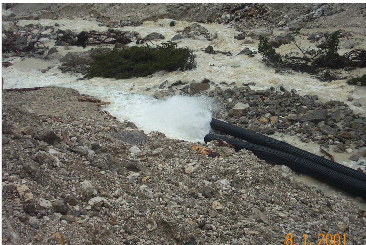
Slika 1 in 2: Odvodni sistemi učinkovito odvajajo nizke (stalne) vode zalednih hudournikov in Mangrtskega potoka
