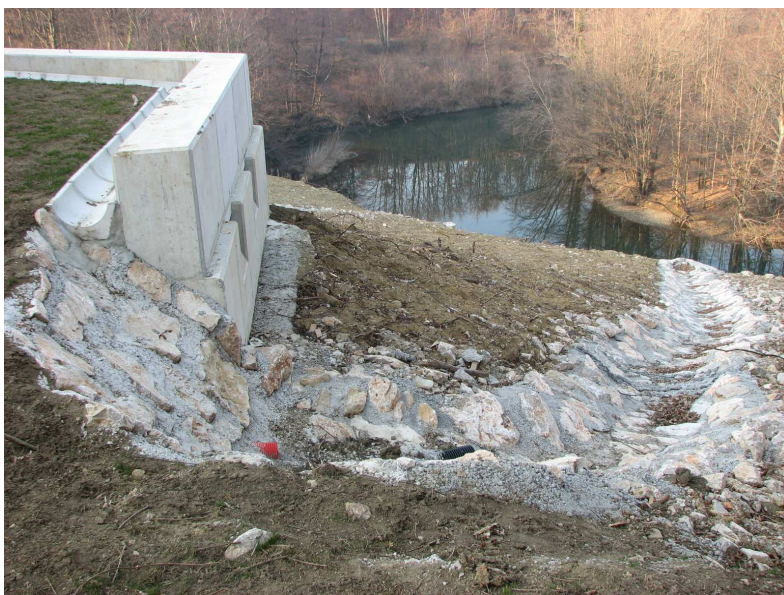
Slika 2: sanacija plaza in odvodnjavanje
