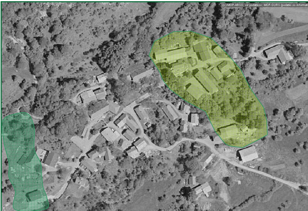
Slika 4: Območje z močno poškodovanimi objekti
